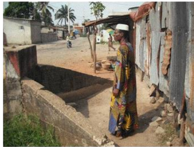
Photo 5 : Construction d'une habitation en matériau précaire à la sortie d'un caniveau à Lokokoukoumè
