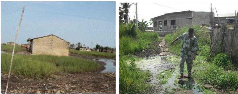
Photo 6 : Construction de maisons en zone inondable (marécages)
