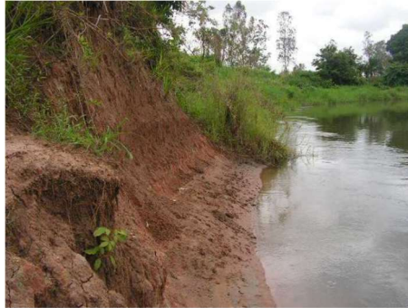
Photo 1 : Erosion des berges à Bopa
