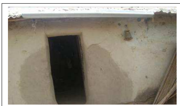
Photo 7: Gouttière servant à récupérer l'eau pluviale Cliché Afoudah et Hédiblè, février 2010
