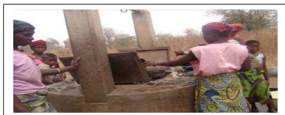
Photo 4 : Puits à grand diamètre construit par l'Organisation Néerlandaise de Développement (SNV) dans le village "Gnel Djaouga" en Mars 1991 Cliché : Hédibè, février 2010
