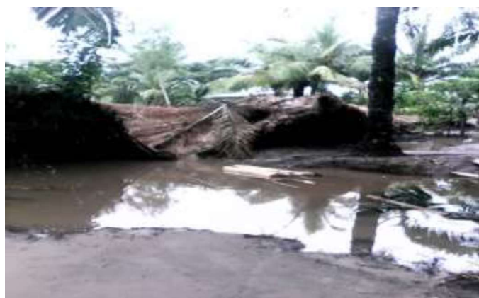
Photo 2 : Chute d'habitat à Ahoho
