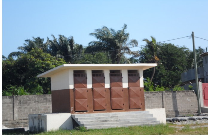
Photo 1. Vue partielle de Latrines de 4 cabines réalisées au complexe scolaire d'Agbalilamè
