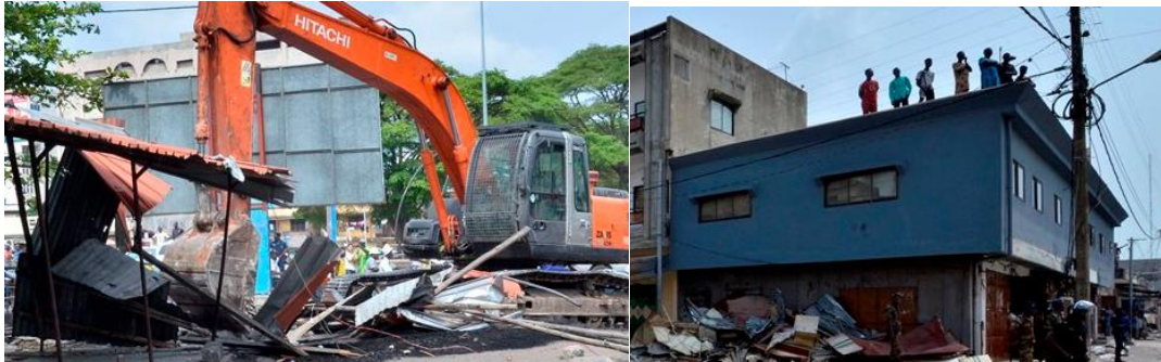
Photo 4 et 5 : Pelleteuse démolissant un hangar de Source : Jeune Afrique
