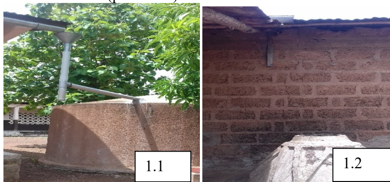
Planche 1 : Citernes d'eau en béton au CEG de Logozohè (1.1) et à Bamè (1.2)
