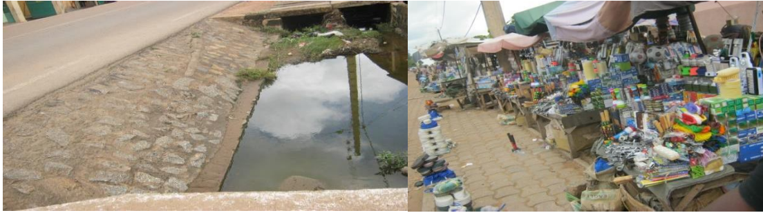
Planche 5: Caniveaux des artères principales et les installations marchandes sur ces derniers dans la ville de Dassa-Zoumé
