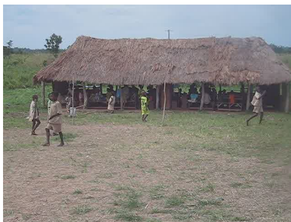
Source : ZANNOU S., photo prise en octobre 2010.
