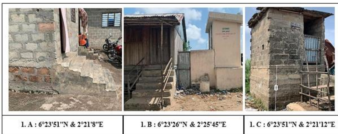
Planche I : Construction en dur surélevée (A) ; Habitat en matériau précaire et toilette surélevés (B) ; Toilette surélevée (C)
