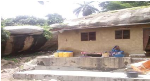
Photo 12 : Construction de terrasse de renforcement de logement
