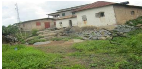
Photo 7 : Maisons construites sur un versant d'une colline de la ville de Dassa-Zoumé
