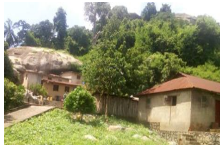
Photo 13 : Fondation de maison en granite, solution pour la platitude
