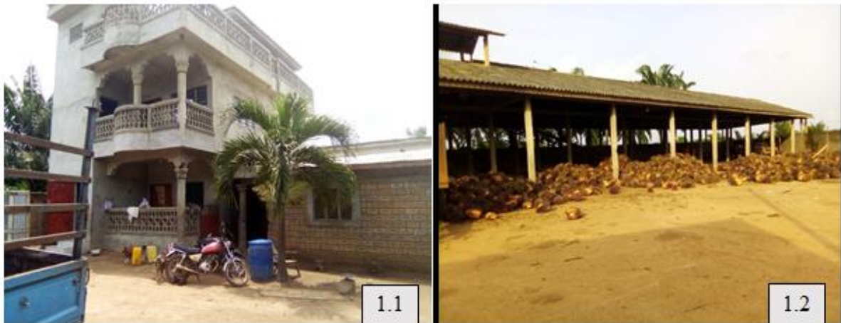
Planche 1 : Résidence et entrepôt sur une ferme moderne à Sakété II
