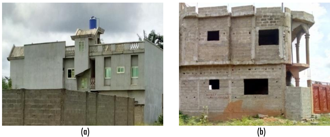
Photo 3 : Images d'habitation moderne (a) et d'habitation moderne en construction à Ouanho (b) Prise de vues : Zannou, août 2019
